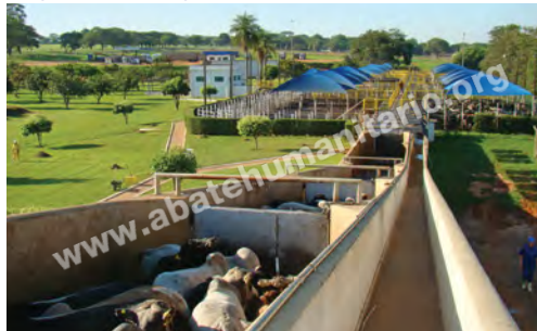
Instalações do manejo pré-abate no frigorífico
