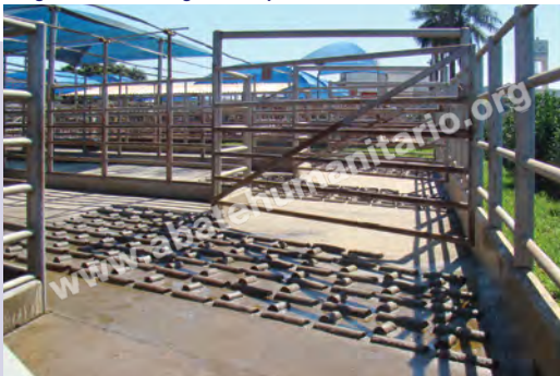
Piso antiderrapante na entrada do curral
