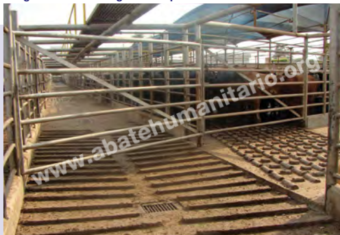
Piso antiderrapante que pode ocasionar deslizamento lateral
