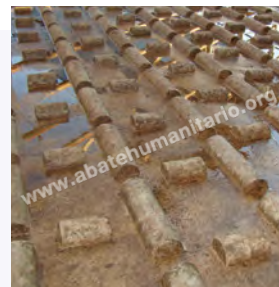
Estrutura antiderrapante com piso concretado com bloquetes
