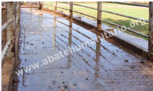
Mudança de piso com contrastes de cor e ralo mal posicionado atrapalham o manejo
