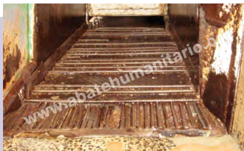
Mudança de piso com contrastes de cor e ralo mal posicionado atrapalham o manejo
