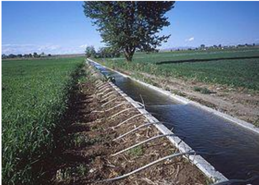
Canal de irrigação com sistema de sifão.
