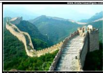
Muralhas da China Início 400 aC Altura 7.5m e 7.300 Km
