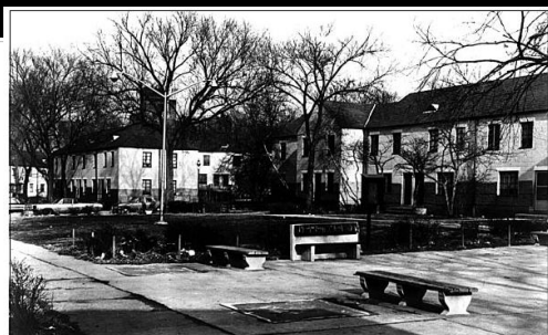
Área comum antes de intervenção
