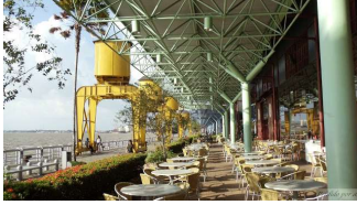
Estação das Docas – Belém, Pará
