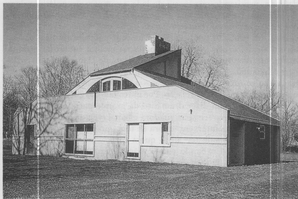
Idem (fachada lateral).
