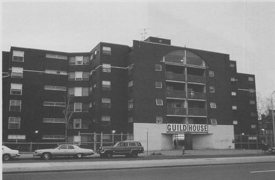
Venturi e Rauch, Guild House , Filadélfia, 1963.
