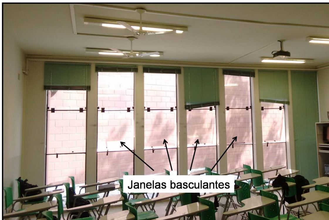
Figura 4 – Janelas basculantes atuais nas salas de aula.
