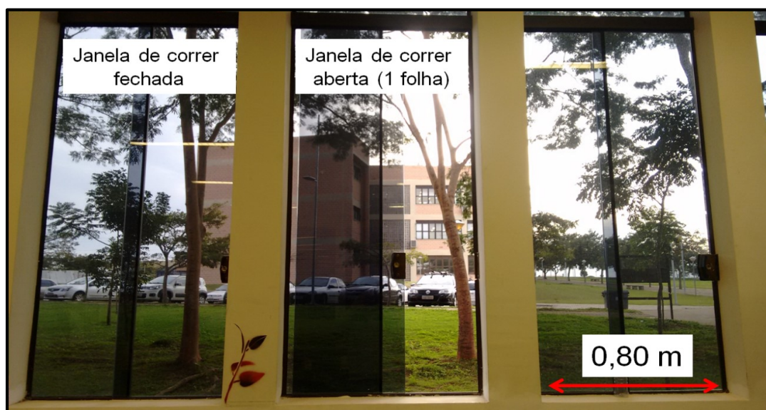
Figura 3 – Tipo de janela pretendida na mudança.
