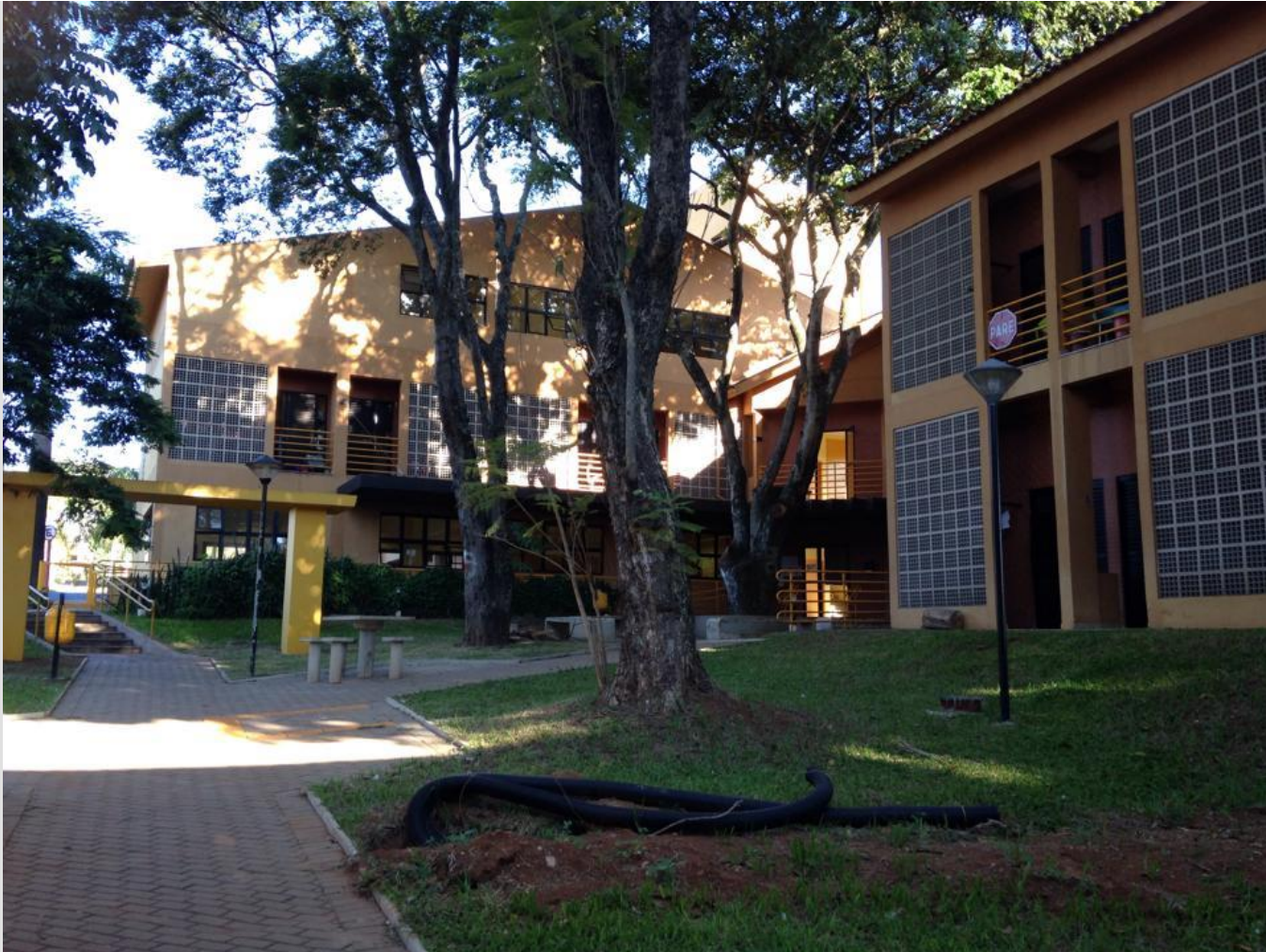
Áreas permeáveis e pavimento permeável na área externa do alojamento Bloco E. Maio 2014
