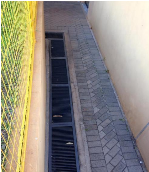
Grelhas coletoras de águas – redirecionamento à rede do campus. Maio 2014
