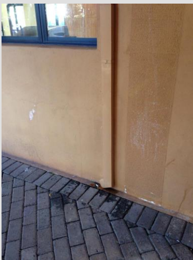
Dois condutores verticais da edificação. Água liberada direto no calçamento permeável. Maio 2014
