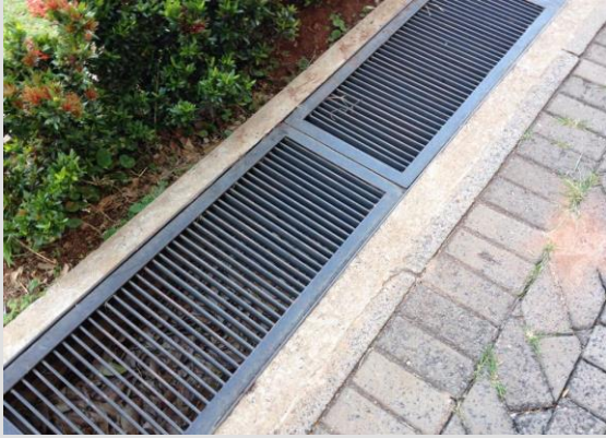
Grelhas coletoras de águas – redirecionamento à rede do campus. Maio 2014
