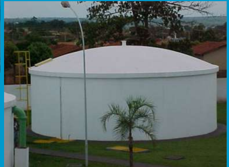
Reservatório da cidade de Riolândia
