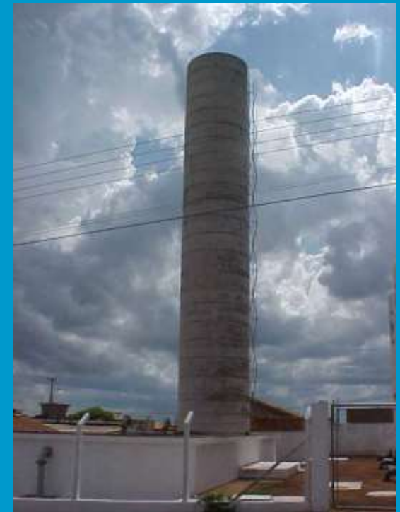
Reservatório da cidade de Franca
