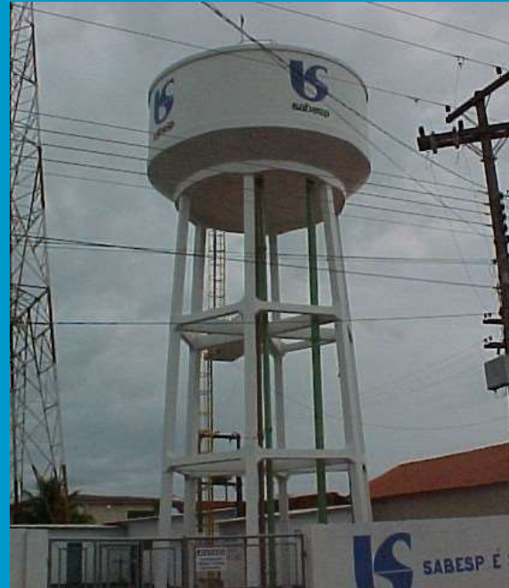
Reservatório da cidade de Riolândia
