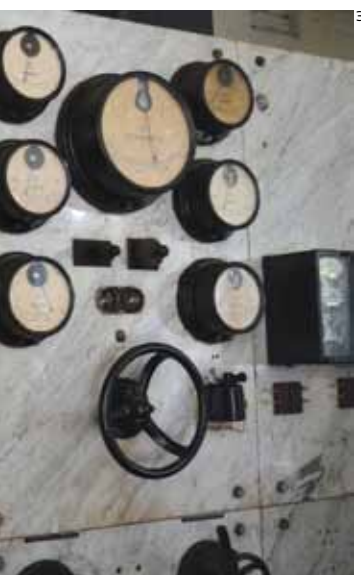
Painel de controle em mármore de Carrara, de 1912, da usina Santa Alice, em São José do Rio Pardo: ainda em funcionamento
