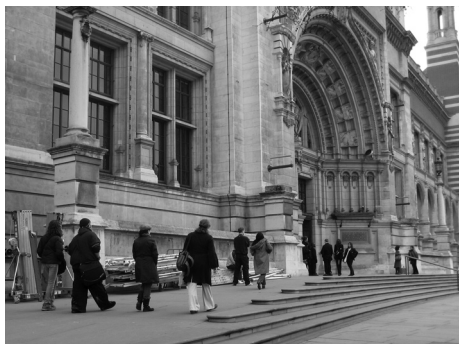
Figura 07: Acesso principal com escada e rampa de acesso do Victoria and Albert Museum de Londres - Inglaterra. Foto: Núcleo Pró-Acesso/ UFRJ.
