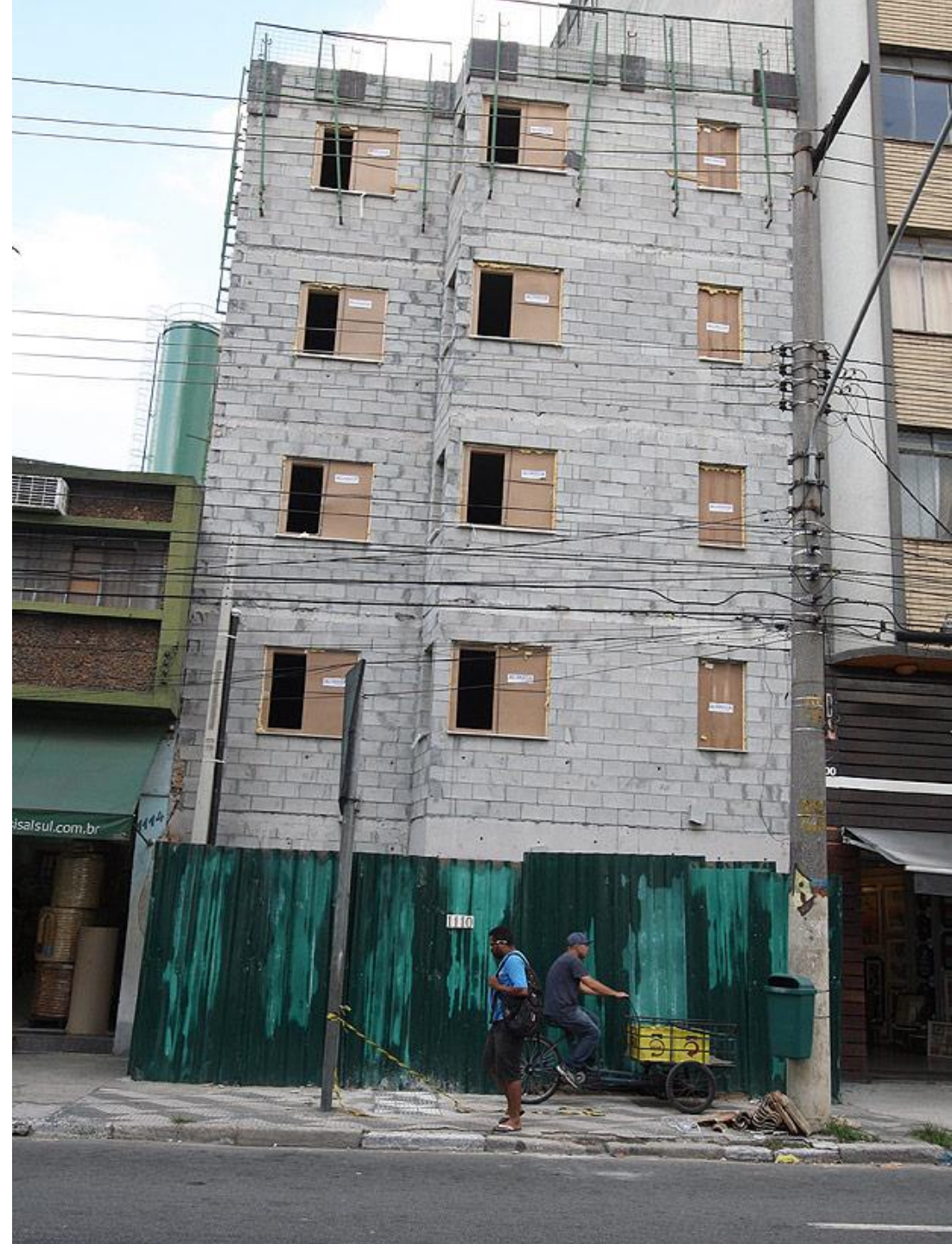
OBRAS NA RUA SÃO CAETANO
