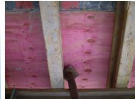
Aspecto da chapa vista por baixo
