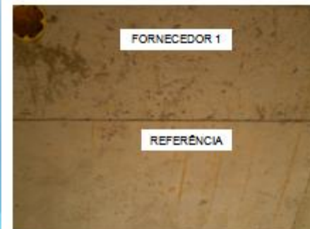
Aspecto do concreto visto por baixo
