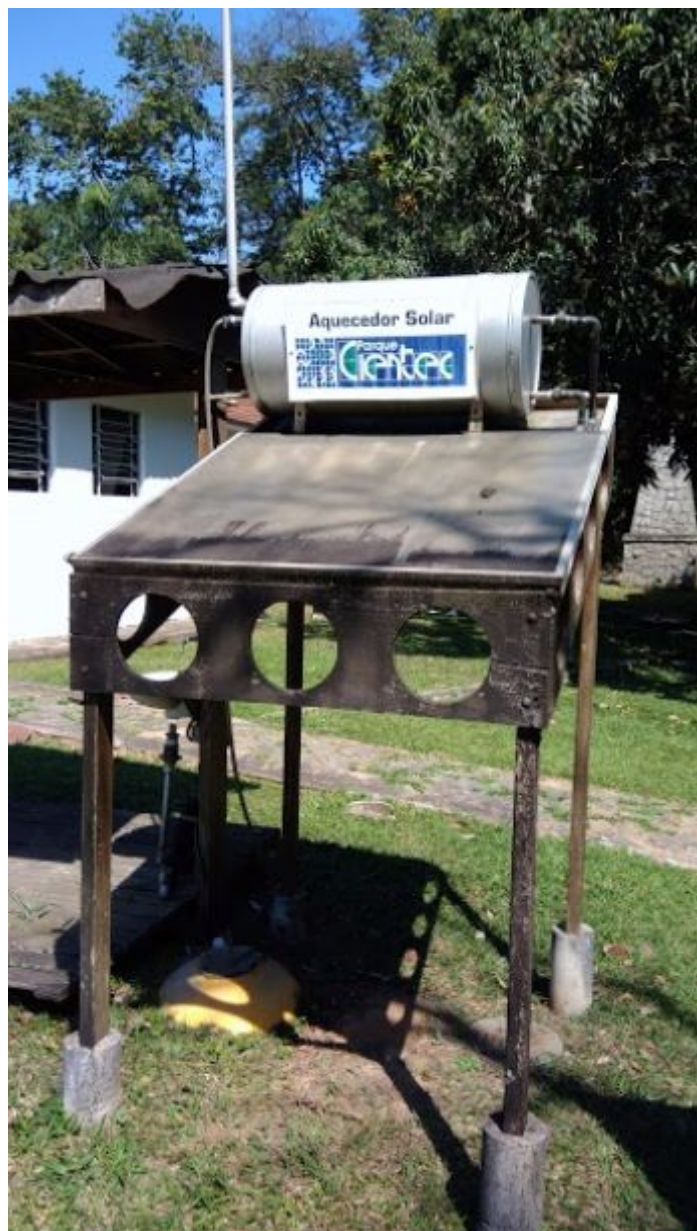
Figura 3. Aquecedor solar. É possível perceber o mau estado de conservação, que se repete em diversos pontos no Parque Cientec.
