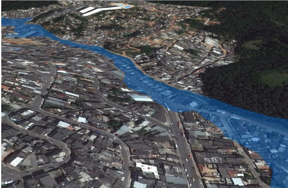
Manchas de inundação
