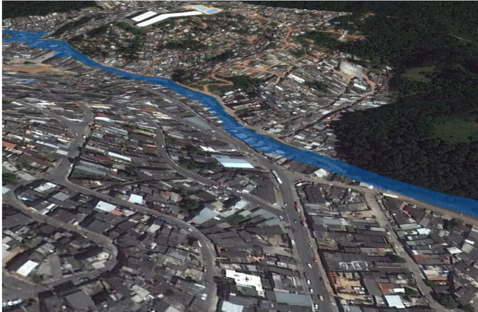
Manchas de inundação
