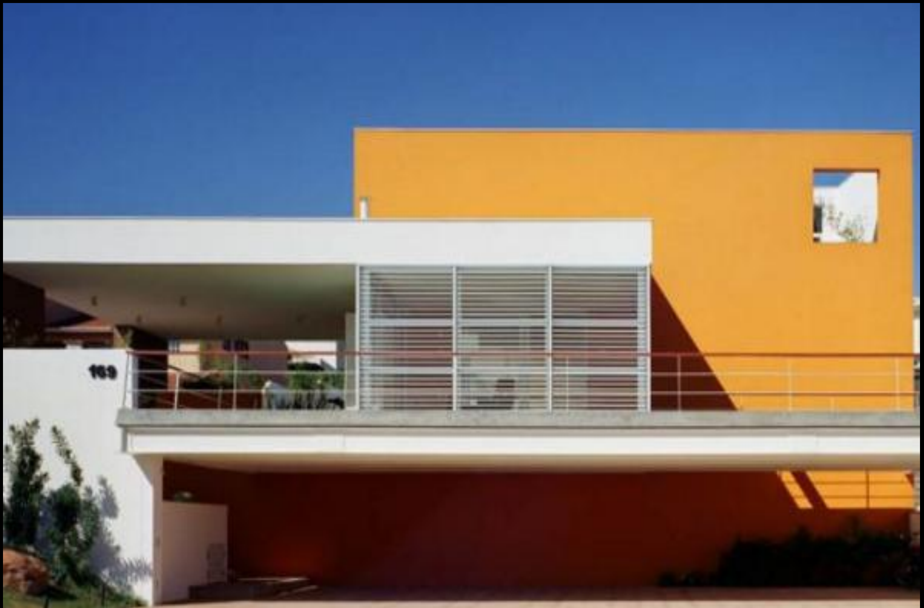
Residência – Casa Arquitetura
