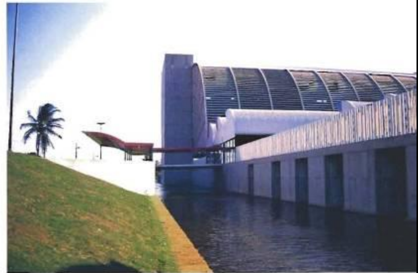
Espelho d'água com tomadas de ar das galerias. Water glass with air intakes of the passages.
