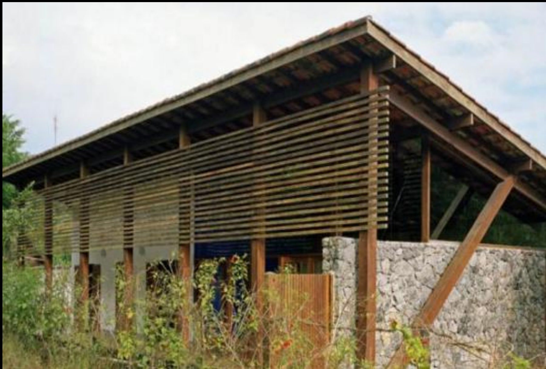
Casa de Praia - Alvaro Puntoni
