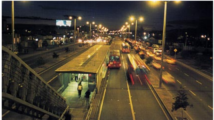
Fig. 20.26 The Calle 80 corridor in Bogotá.
