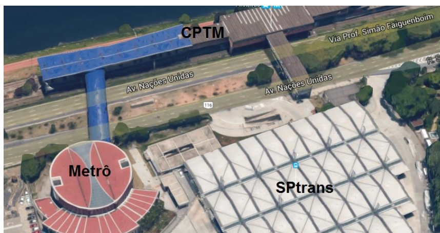
Figura 10: Vista aérea do Terminal Pinheiros
