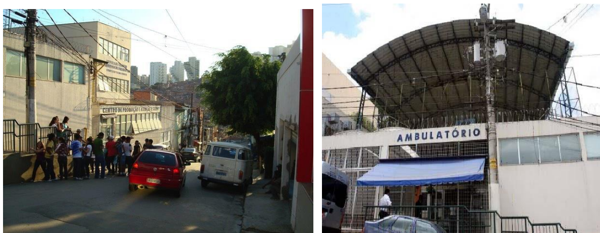
Fig.9 e 10 - Vistas da fachada do Programa Einstein em Paraisópolis Fotos: acervo da PECP
