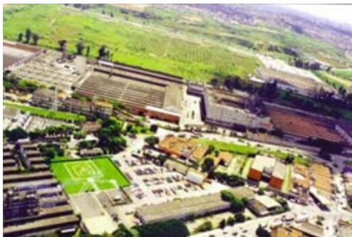
Fábrica Pirelli, área de intervenção do Projeto Eixo Tamanduatehy, Prefeitura de Santo André
