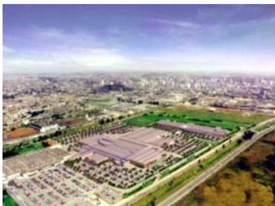
Vista geral da proposta de intervenção. Projeto Eixo Tamanduatehy, Prefeitura de Santo André
