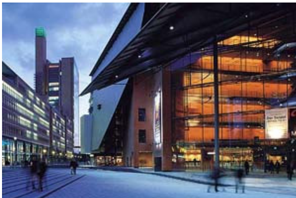
Teatro em Potsdamer Platz. Foto Vincent Mosch. Fonte: Renzo Piano Building Workshop
