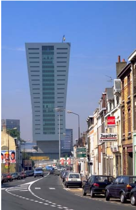
Torre do Crédit Lyonnais de Euralille, Lille, 1995. Arquiteto Christian de Portzamparc, projeto urbano de Rem Koolhaas. Foto Nicolas Borel
