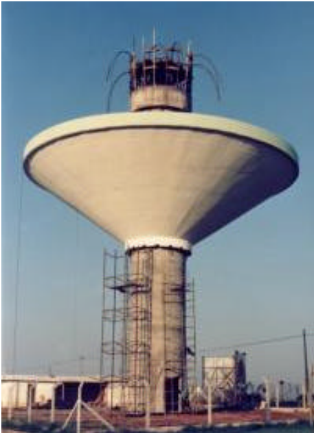
Elevação de reservatórios.
