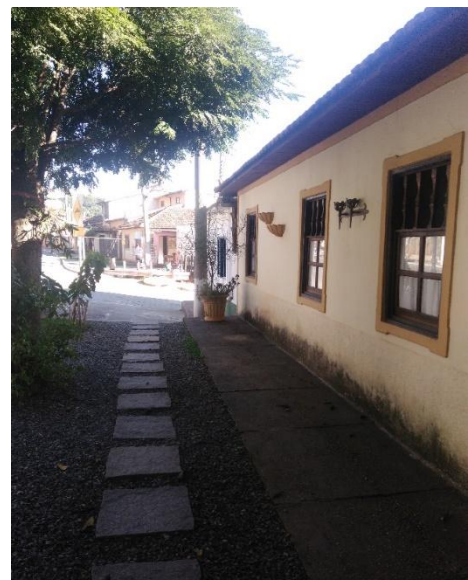
Figura 11 - Casa estilo Colonial. Fonte: Camila Costa 04/06/2017
