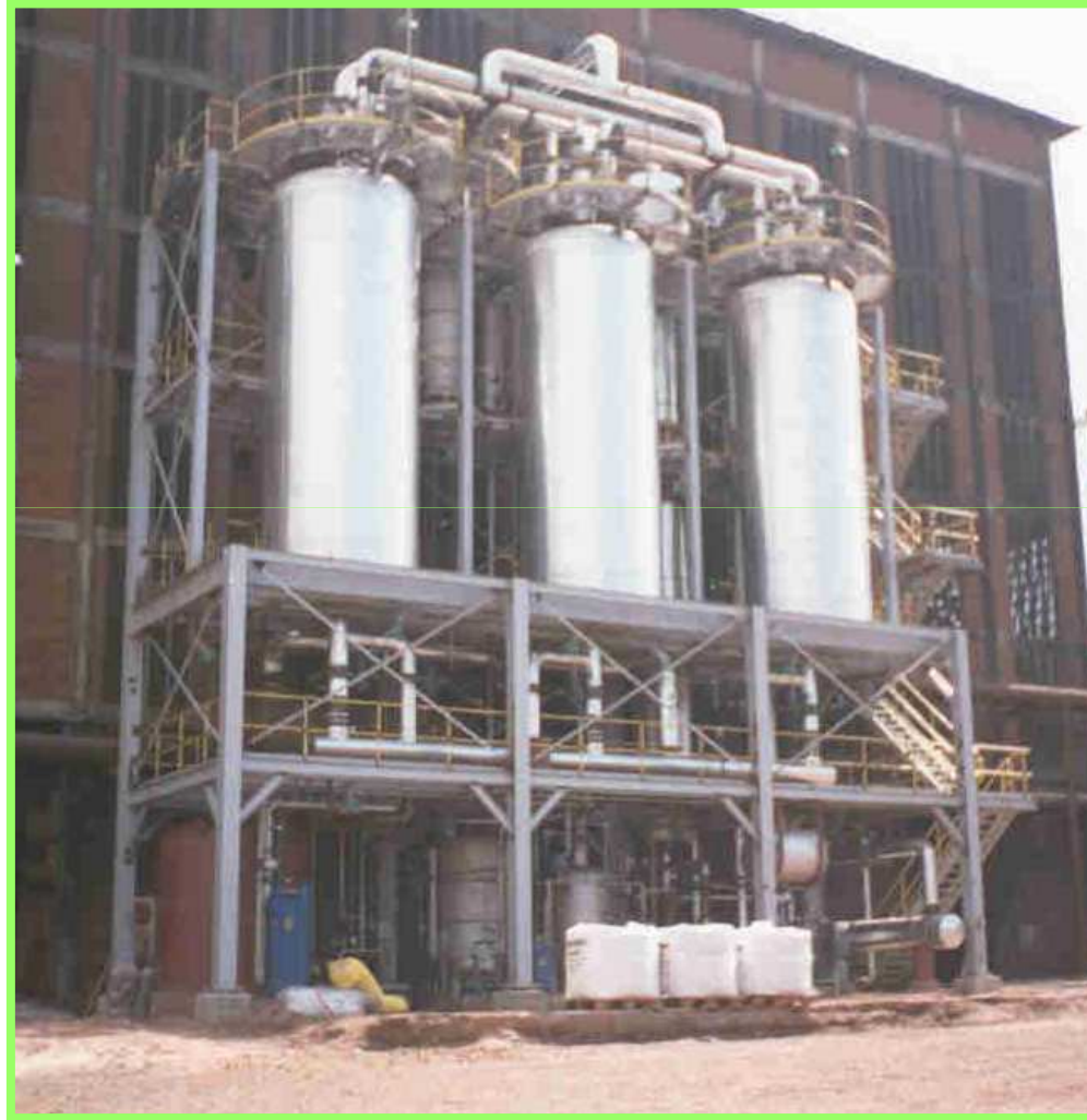
Unidade de Desidratação via Peneira Molecular
