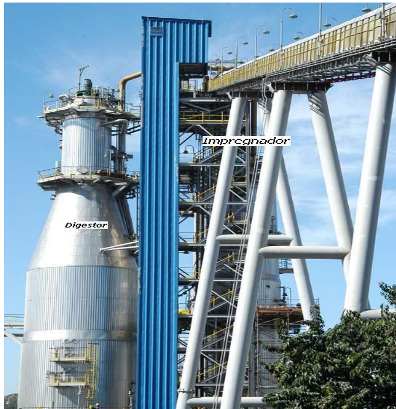
Figura 4 - Digestor utilizado no processo de produção da celulose
