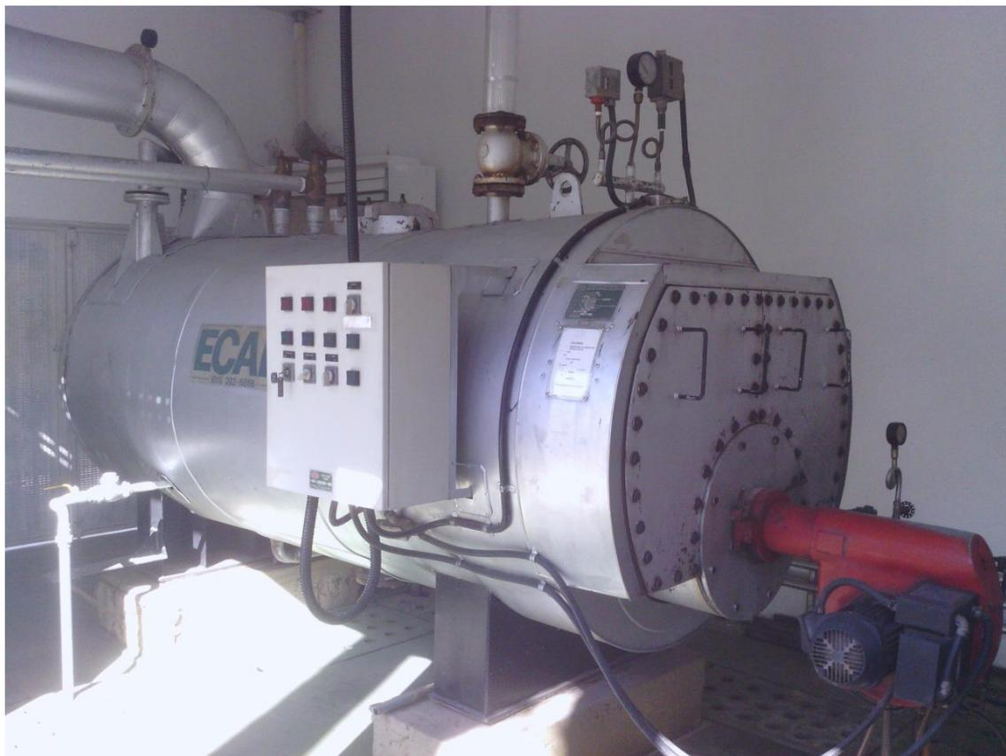
Figura 3: Aquecedor de água principal
