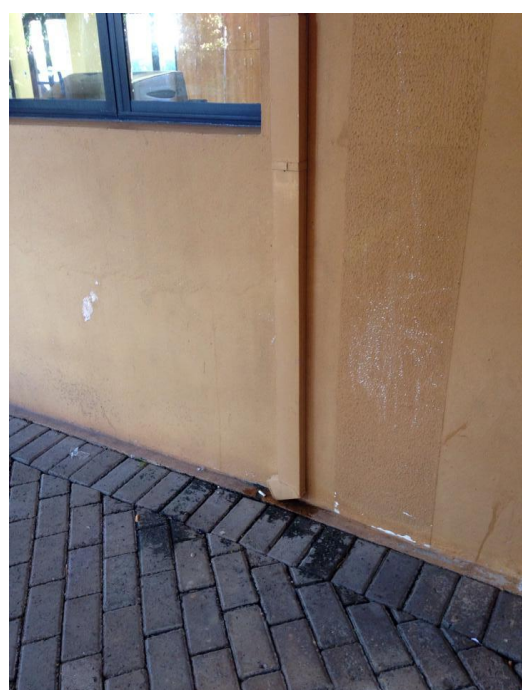
Imagens do condutor liberando a água no calçamento permeável. Maio 2014.
