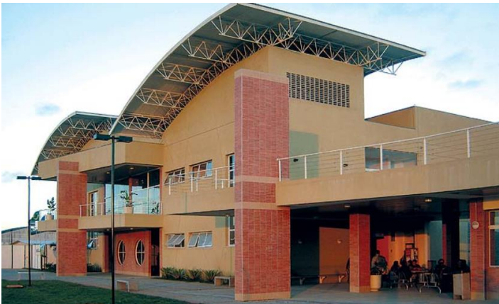
Figuras 30 e 31: Telhas metálicas.
