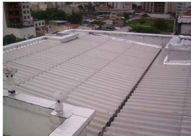
Figura 17: Telhado de fibrocimento.
