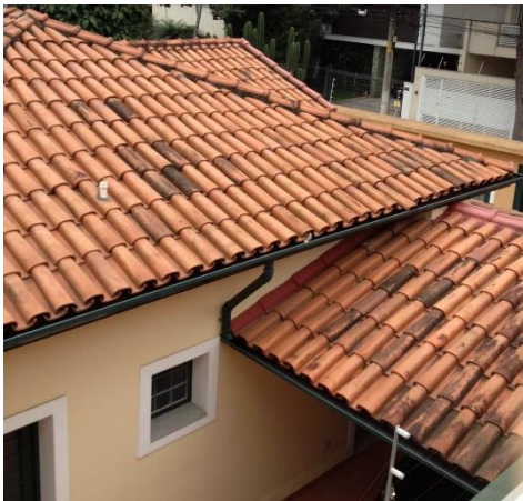
Figura 66: Beirais. Fonte: MOLITERNO, Antônio (2007 p. 6).
