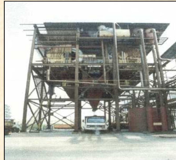
Descarregamento do lodo em filtro de 13" x 32"
