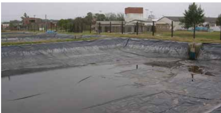
FIGURA 3 | VIVEIRO RECOBERTO COM GEOMEMBRANA (PEAD); ESTAÇÃO MARINHA DE AQUACULTURA/IO/FURG, RS, 2009
