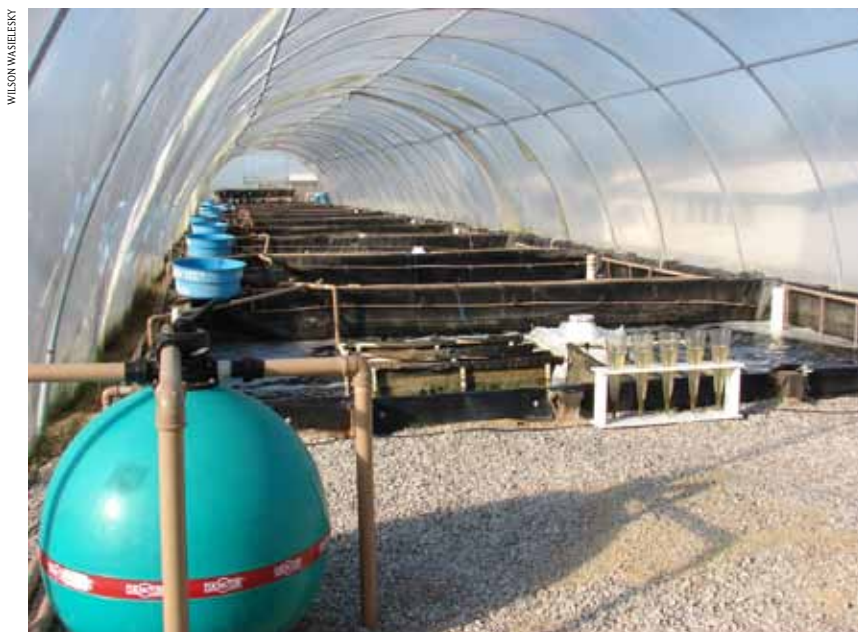
FIGURA 2 | ESTUFA (585M 2 ) PARA TESTES PILOTO COM TANQUES REVESTIDOS DE GEOMEMBRANA® (PEAD) NA ESTAÇÃO MARINHA DE AQUICULTURA DA FURG; RIO GRANDE, RS
