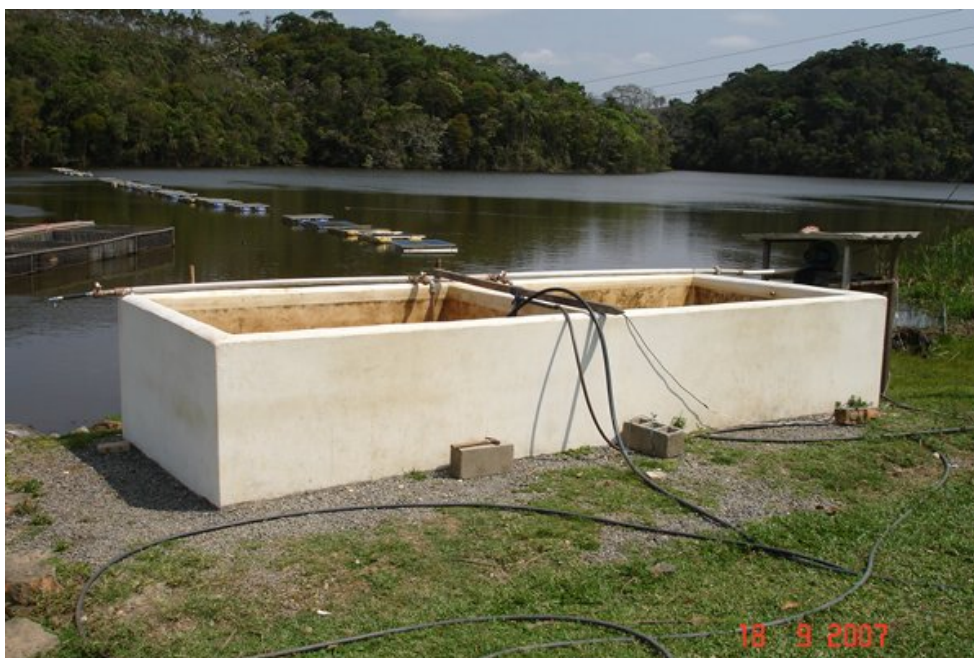
Figura 6 – Tanque de depuração
