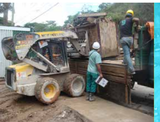
Retirada de resíduo de madeira da obra.
