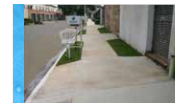
Trecho de calçada revitalizado conforme conceito da Calçada Consciente.
