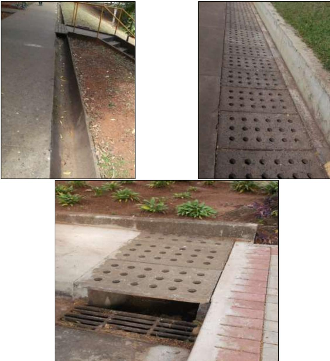
Figura 10 - Sistema de drenagem de águas pluviais (Fonte: Pâmela Dias, Maio/2014)
