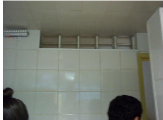
Elemento vazado do banheiro, aberto para o corredor
