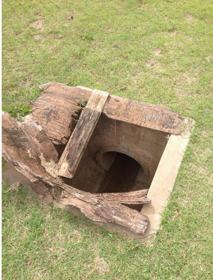
Figura 10 - Caixa de escoamento de água pluvial
