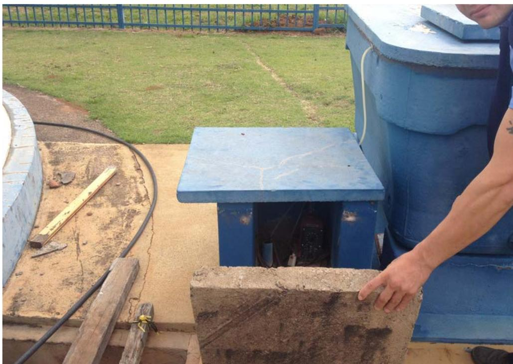
Figura 5 - Tanque de cloração e bomba dosadora
