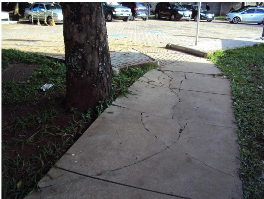
Figura 4 – Calçada danificada por raízes da árvore. Acesso ao ICMC.
