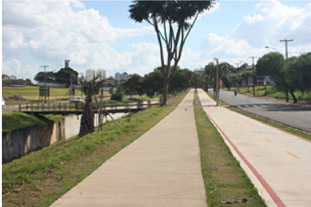
Figura 25: Ciclovía do comércio - Trecho SESC - boa sinalização, possui travessias para os dois lados da avenida, vegetação em crescimento, seguro em relação aos veículos, porém é necessário proteção que resguarde o ciclista da vala de canalização do rio
