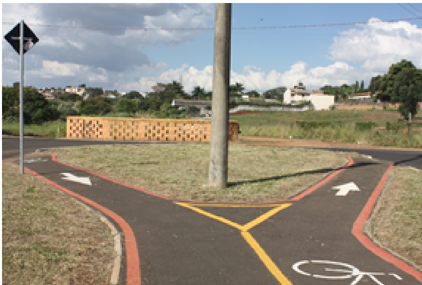
Figura 30: Ciclovia dos estudantes - pintura ainda boa em alguns trechos, porém possui problemas de sinalização para os motoristas, cruzamentos e acessos mal sinalizados e executados
