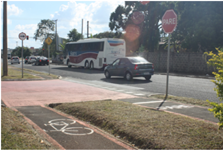
Figura 29: ciclovia dos estudantes - pintura ainda boa em alguns trechos, porém possui problemas de sinalização para os motoristas, cruzamentos e acessos mal sinalizados e executados
