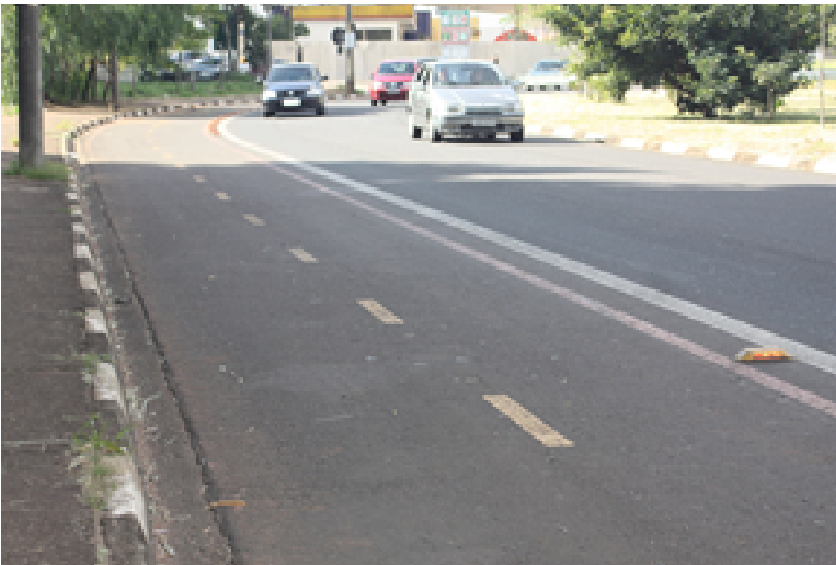
Figura 27: ciclovia das artes - falta de sinalização para os motoristas, pouca proteção devido à velocidade dos carros, tarugos arrancados pelos veículos, uso da ciclofaixa como acostamento
