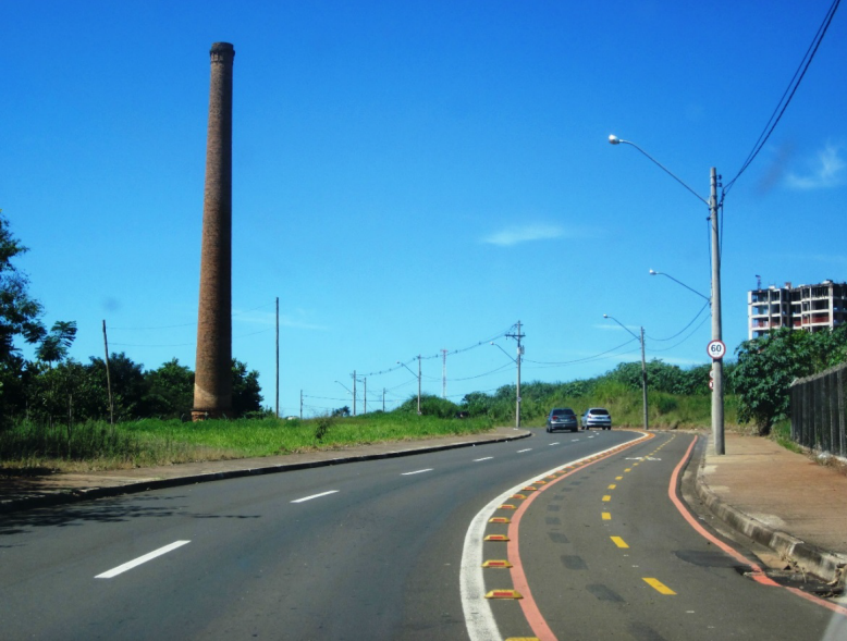
Figura 24: Ciclovía do Comércio- Trecho da Chaminé - falta de sinalização para os motoristas, pouca proteção devido à velocidade dos carros, uso da ciclofaixa como acostamento, ausência de vegetação
