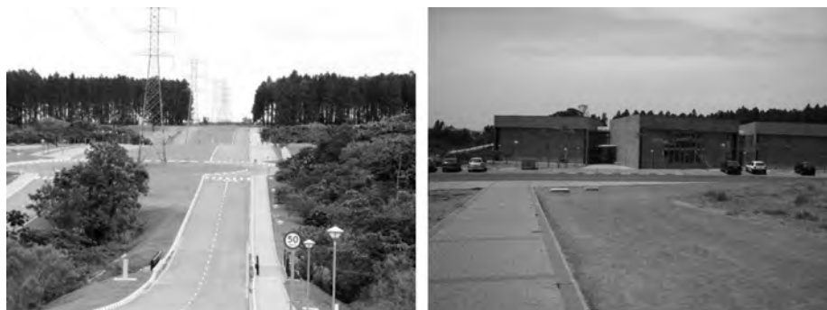
Figuras 4 e 5 - Imagens do Campus 2: acesso principal e caminho até o edifício da Engenharia Ambiental
