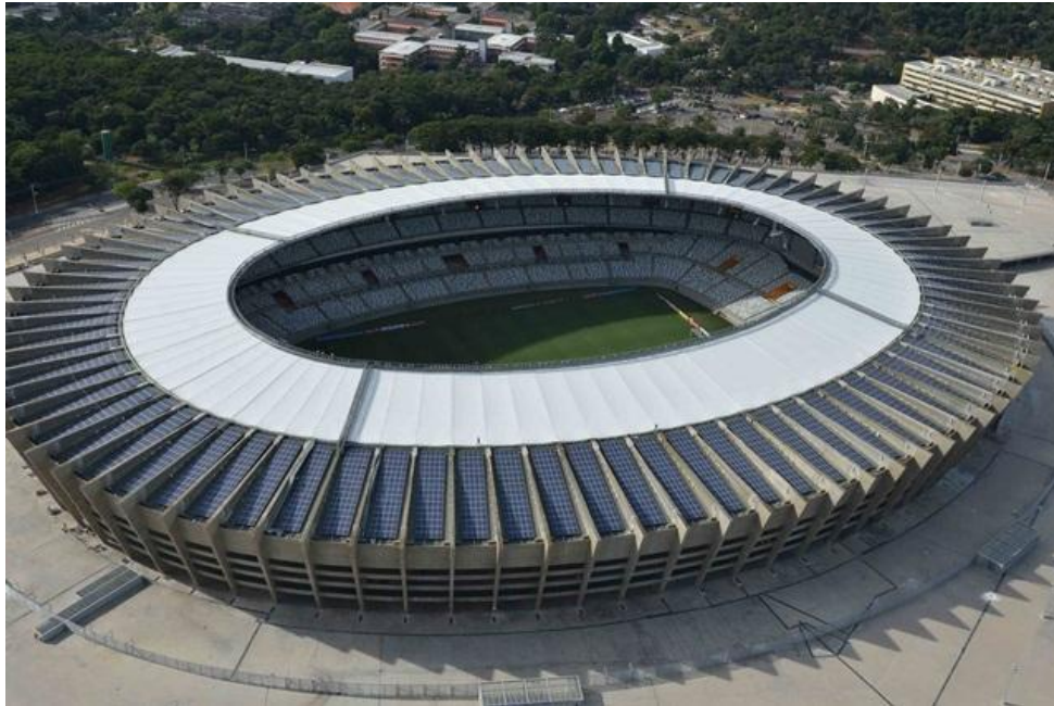
Figura 3- Estádio governador Magalhães Pinto, o Mineirão, com placas fotovoltaicas em sua estrutura
