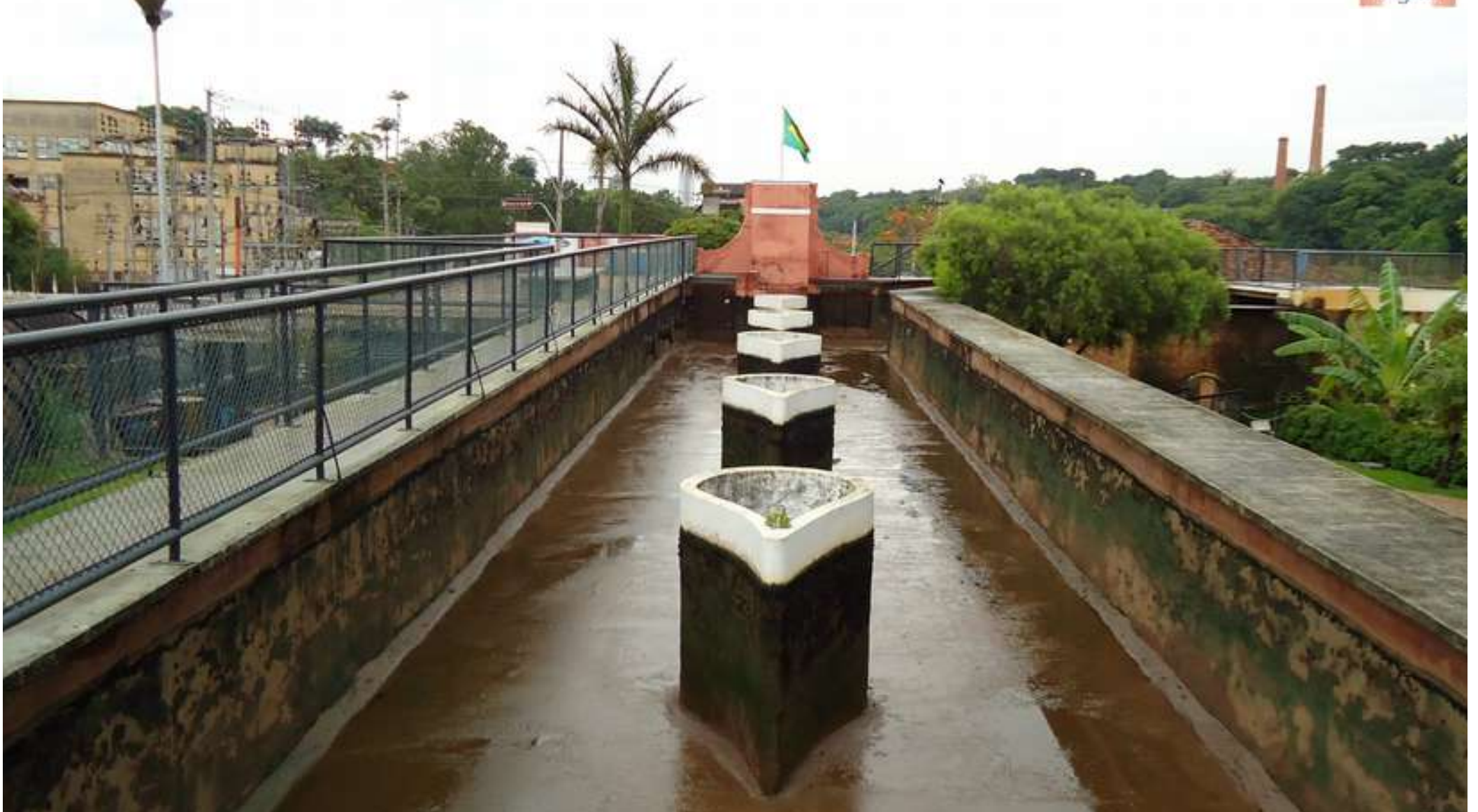
Canal, em dia de limpeza, por onde era levada a água utilizada para acionar as hidrobombas, na Casa de Bombas. Atualmente, direciona a água até a Cascata do Mirante.
