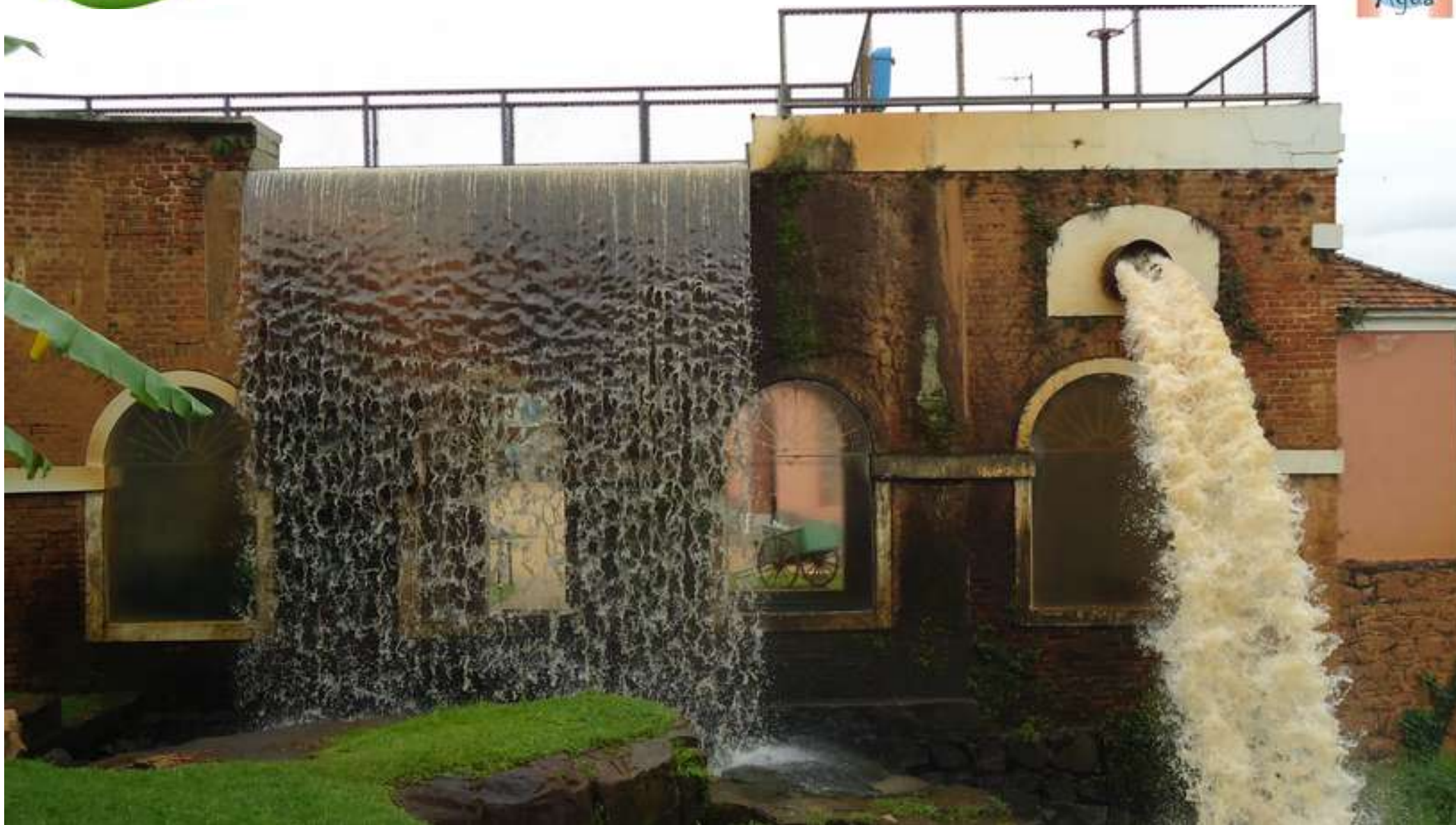
Vista oposta do terceiro aqueduto, onde está situada a Cascata
