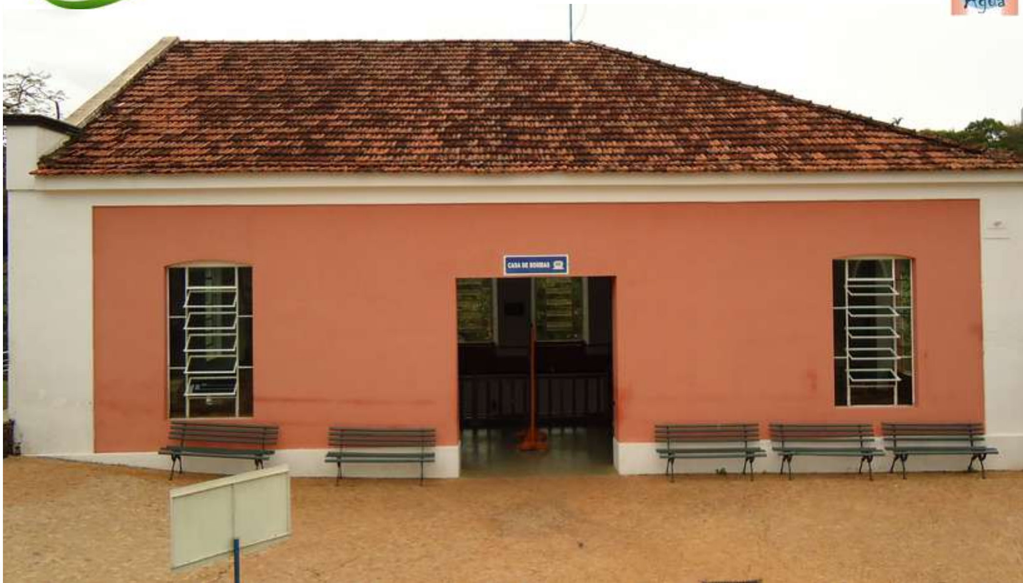
Vista parcial frontal da Casa de Bombas
