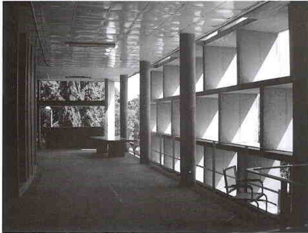
Fig. I.4 Espaço de circulação externa do edifício do Parlamento em Chandigarh, na Índia, projetado por Le Corbusier. A fachada composta pela combinação de elementos horizontais e verticais traz proteção contra o impacto do sol, enquanto cria um ambiente de transição entre exterior e interior
