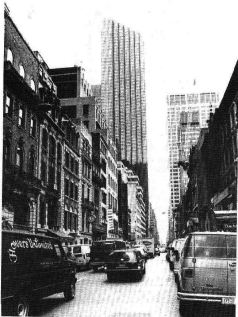
Ilustração 1.13 O modernismo da Trump Tower (esquerda) briga com o pós-modernismo do prédio da AT & T, de Philip Johnson (direita), por uma posição no horizonte de Nova Iorque.
