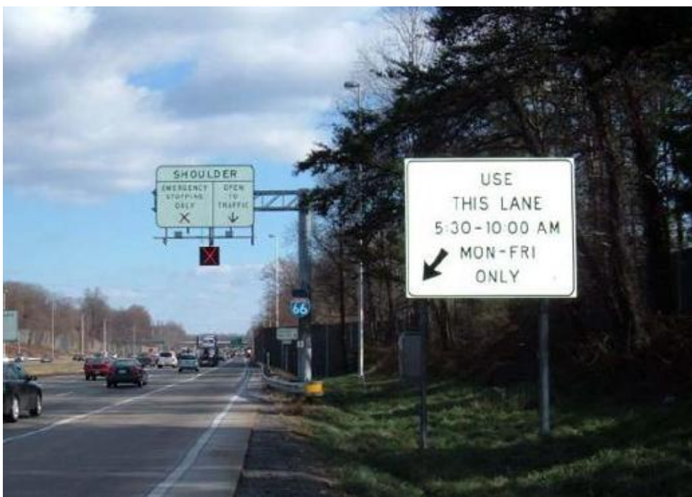
Figura 8 – Utilização do acostamento em horários fixos nos Estados Unidos (Fonte: FERRET, G, M. Avaliação da opinião dos motoristas. 2013)
