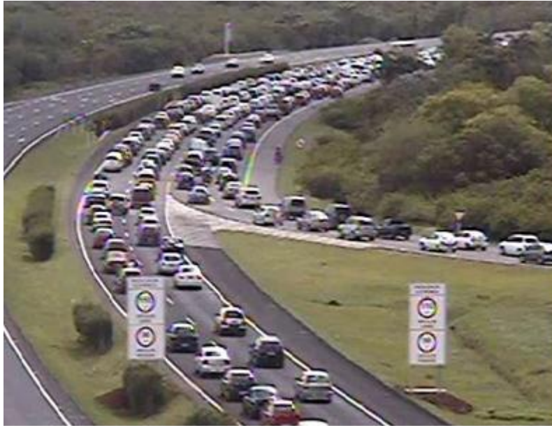
Figura 4 - Condições de operação anteriormente a intervenção
