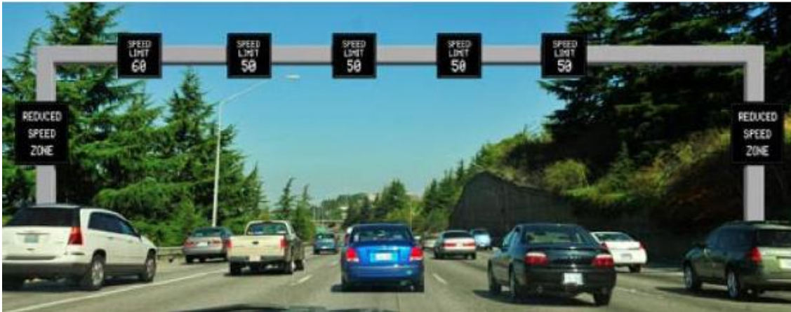
Figura 9 – Harmonização de velocidades e utilização do acostamento interno e externo em Whashington State (Fonte: FERRET, G. M. Avaliação da opinião dos motoristas. 2013)
