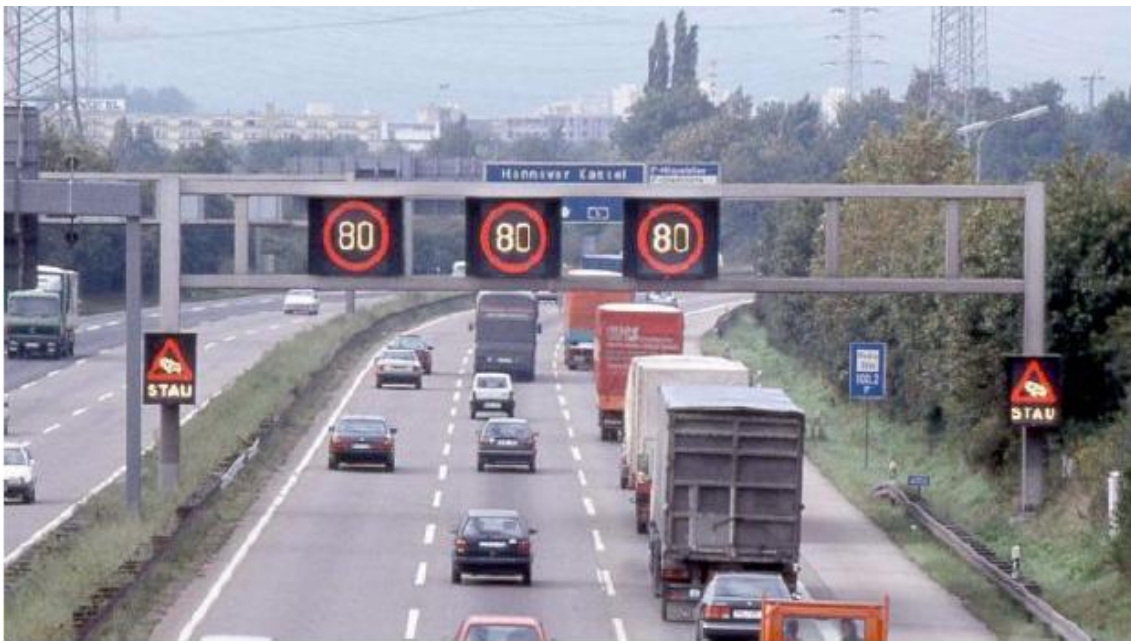
Figura 7 – Exibição de pictogramas simbolizando congestionamento na Alemanha (Fonte: FERRET, G. M. Avaliação da opinião dos motoristas. 2013)
