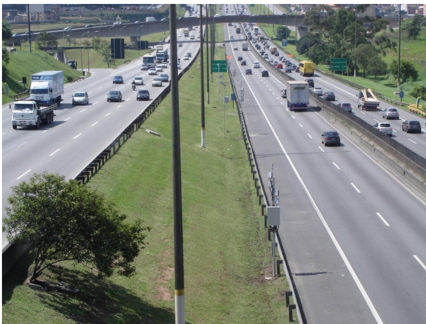
Figura 10 – Equipamentos em testes na Rodovia Anchieta
