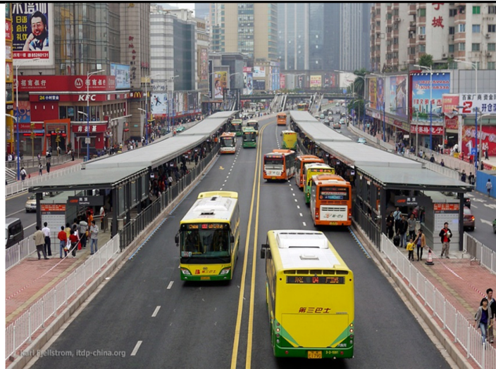
Figura 2-6 - Circulação de ônibus em vias segregada - BRT
