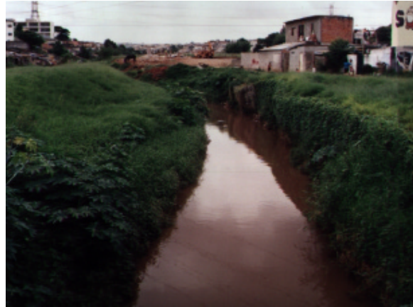
Calha do Córrego Pirajussara, São Paulo.
