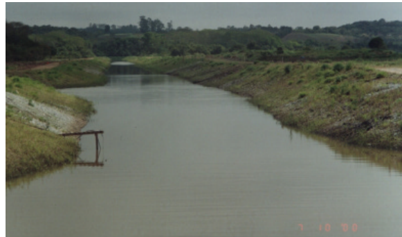
Canal de adução do sistema produtor Alto Tietê – Sabesp – São Paulo, 1999.
