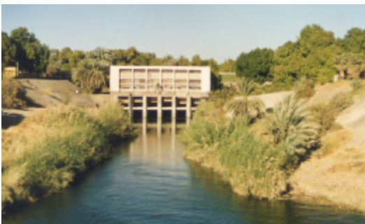
Canal de adução à casa de bombas do sistema de irrigação do Baixo Nilo – Egito, 1999.
