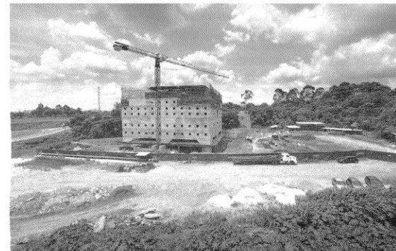
A praça em construção na Cidade Universitária: espaço para ensino, pesquisa e extensão
