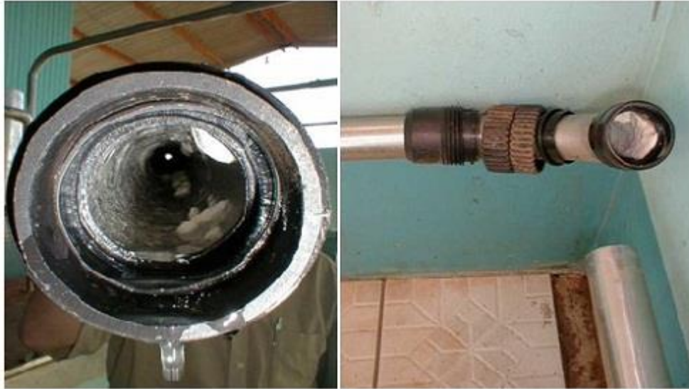
Restos de leite em tubulações de resfriamento
