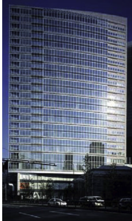
Fig. 5 – Edifício Matsushita Denso no Japão revestido com vidros com super-hidrofilicidade foto-induzida [9]
