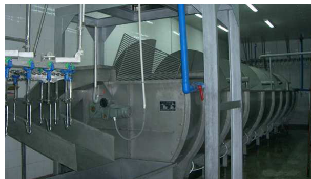
Figura 5. Tanque de chiller, para resfriamento, em espiral. Em: http://www.poultry-slaughter.cn/Poultry-slaughterline/Bleeding-Trough.html
