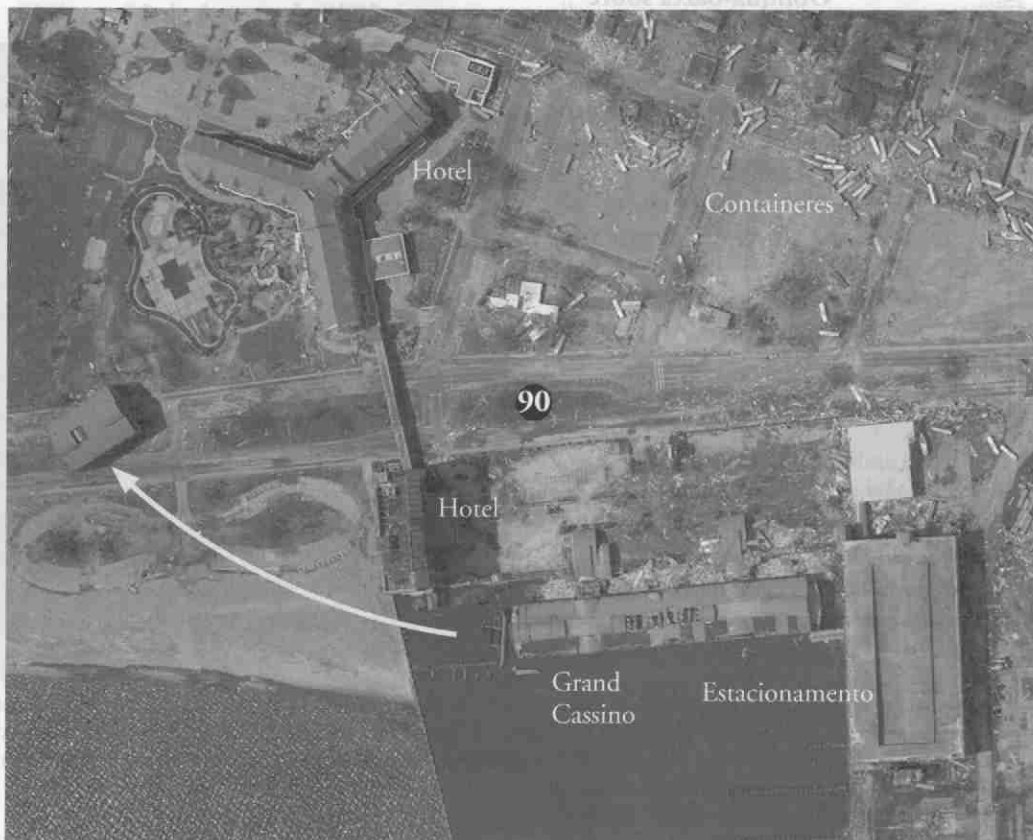
Figura 4-2 Fotografia aérea vertical obtida em 30 de agosto de 2005 registrando os danos causados pelo vento e pela tempestade do furacão Katrina em Gulfport no Estado de Mississippi, EUA (cortesia da Divisão de Sensoriamento Remoto da NOAA).
