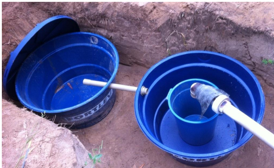
Figura 4.12 – Detalhe do balde de 70 litros dentro do primeiro reservatório e ligação entre reservatórios.
