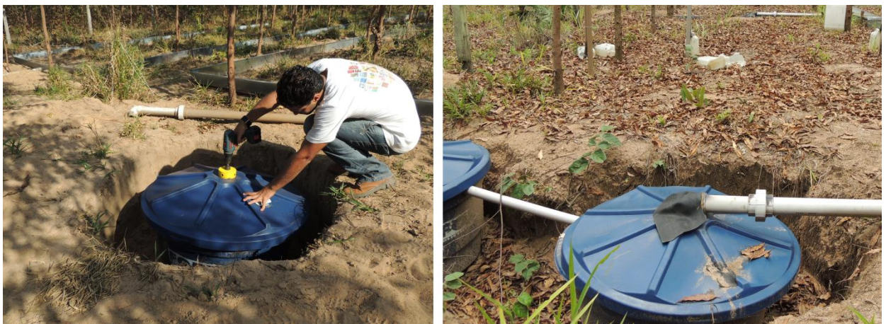
Figura 4.10 – Furo na tampa do reservatório para colocação da tubulação da parcela experimental e manta de borracha protegendo o furo.
