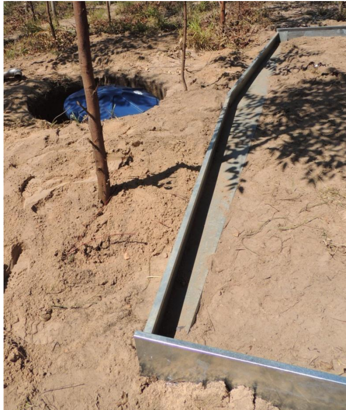
Figura 4.9 – Calha na base da parcela experimental e reservatório enterrado.
